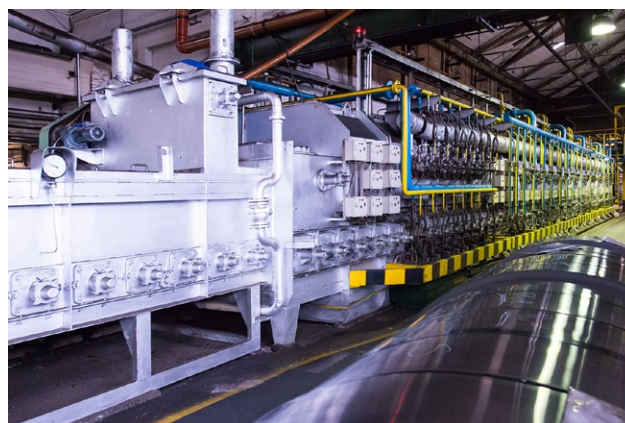
Durchlaufglühanlage der HFP Bandstahl GmbH, © HFP
