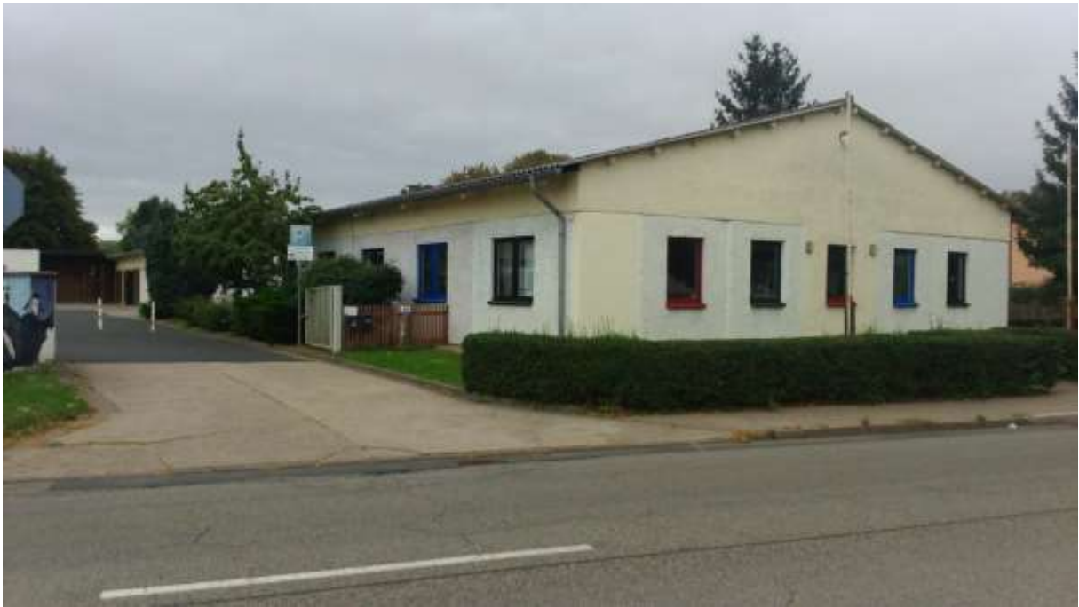
Hauptgebäude Zufahrt von Bundesstraße
